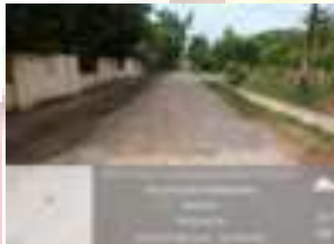
Peningkatan Jalan Poros Kp. Pasuluhan Walantaka
